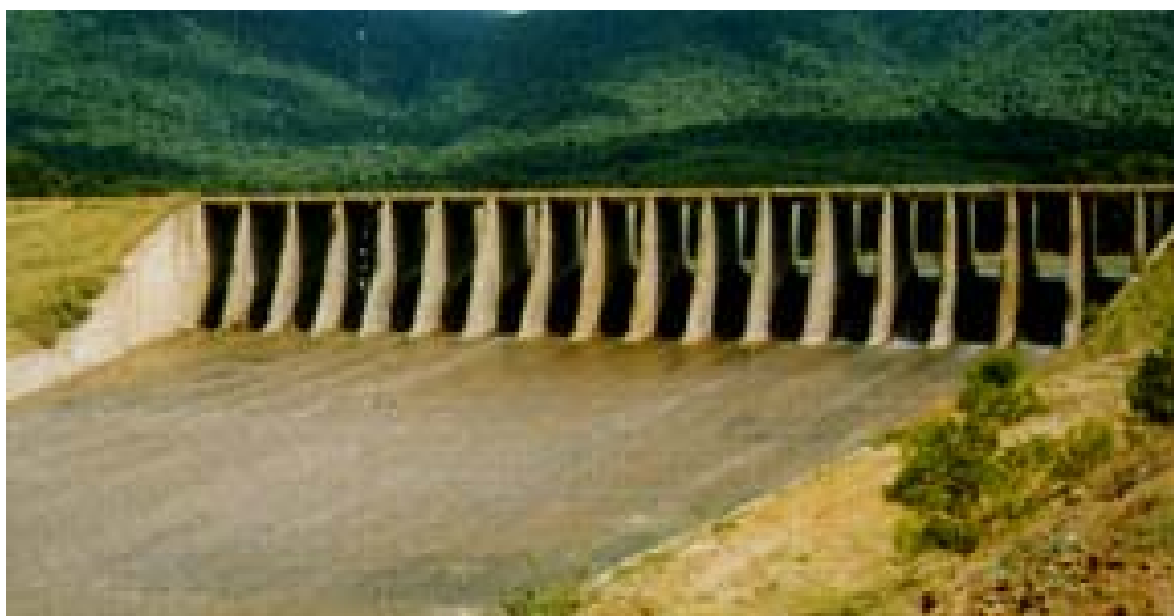
Hình 46: Công trình thoát nước
